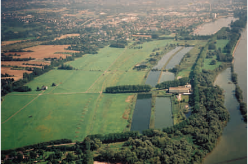
Bild 4.2: Luftbild des Wasserwerks Schierstein, vorne rechts das Rheinwasseraufbereitungswerk, hinten links das Grundwasseraufbereitungswerk
