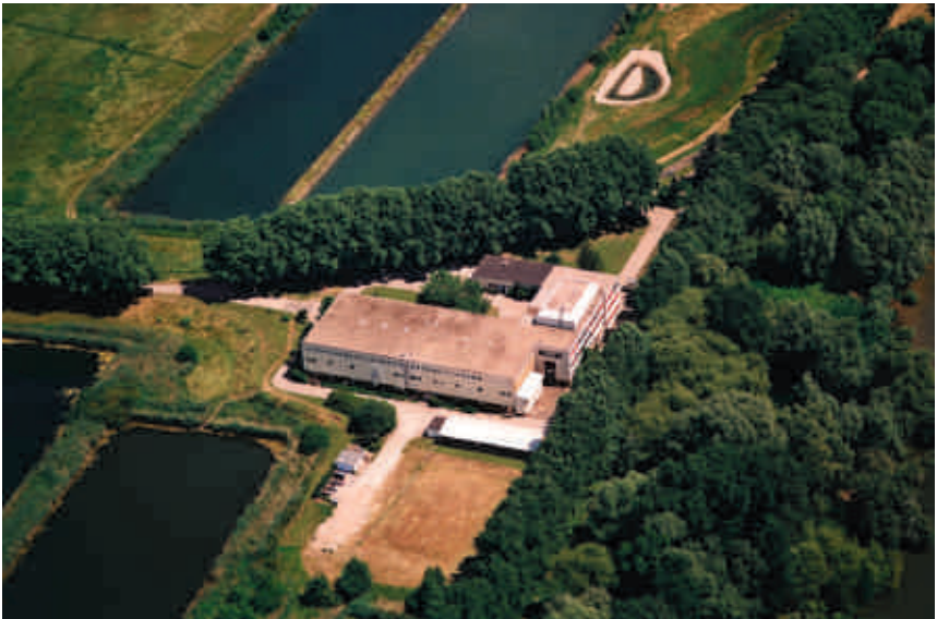
Bild 4.3: Bild 3: Nahaufnahme des Rheinwasseraufbereitungswerks mit Beckensystem 2 und 3
