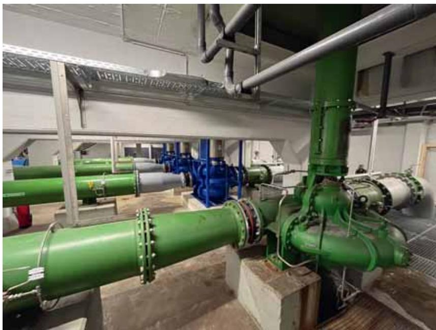
**Bild 4.8:** Im Vordergrund die alte Pumpentechnik, im Hintergrund drei neue Pumpen.
