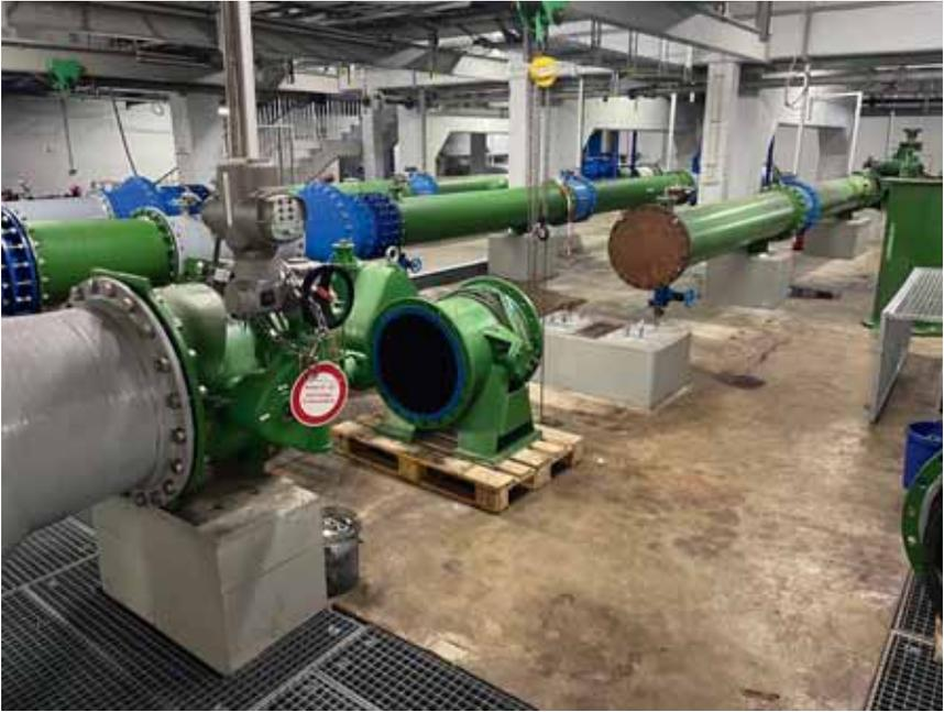
**Bild 4.5:** Im Keller unter dem Maschinenraum des Wasserwerks Holthausen wurden die Netzpumpen im laufenden Betrieb ausgetauscht. Auch ältere Armaturen wurden ersetzt und Fallgewichtsarmaturen gegen Düsenrückschlagventile getauscht.
