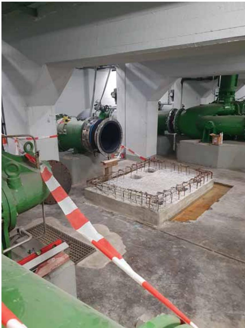
**Bild 4.7:** Neue Fundamente für neuen Pumpen.
