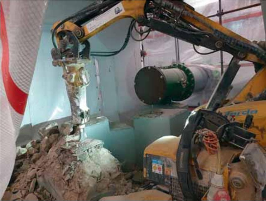
**Bild 4.4:** Schweres Gerät war notwendig, um die Fundamente der alten Pumpen zu entfernen.
