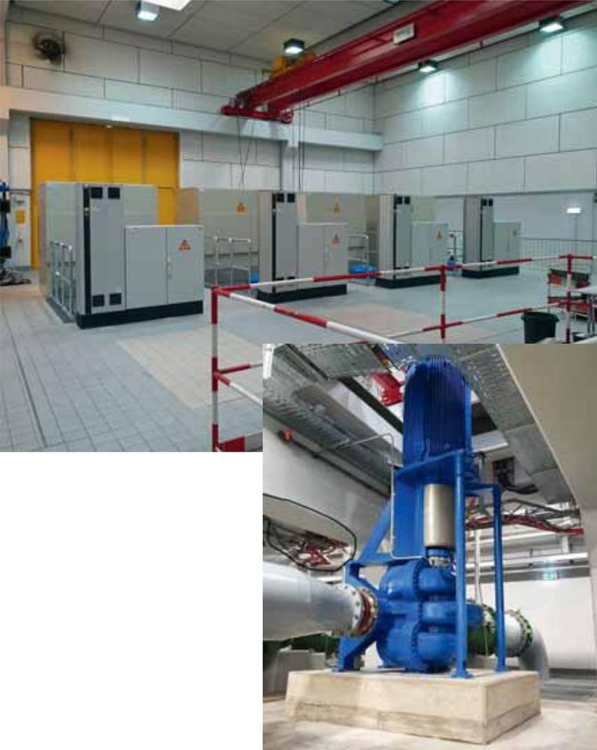
**Bild 4.1/4.2:** In der Maschinenhalle des Wasserwerks Holthausen der Stadtwerke Düsseldorf stehen jetzt die neuen Frequenzumformer, Blocktransformatoren und das jeweilige Leistungsteil der vier neuen Netzpumpen, die im Keller aufgestellt sind. Gut zwei Jahre dauerte ihr Austausch im laufenden Betrieb.
